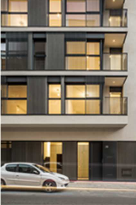
BLOC PC 02 CARRER DOCTOR COMBELLES, LLEIDA Autors: Alventosa Morell Arquitectes. Josep M. Alventosa, Marc Alventosa i Xavier Morell
