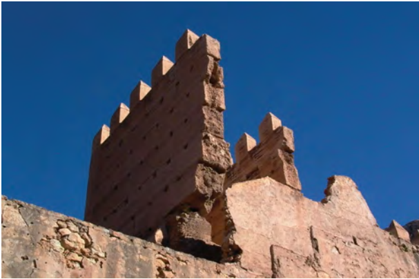
2. Estado inicial de torre H8, con desaparición de más de un tercio de su perímetro.
