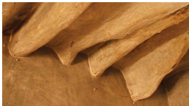
5. Forjado vernáculo de rollizos y tablillas de madera enlucidos de yeso en el Maestrazgo, Castellón.
