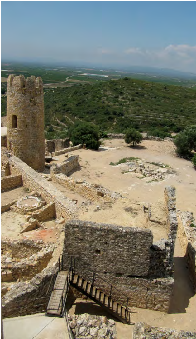
4. Castell d'Ulldecona. Traces del castell andalusí. Celòquia des de l'albacar.
