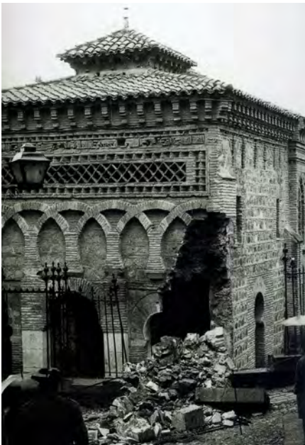
8. Colapso de la esquina suroeste en 1964.
