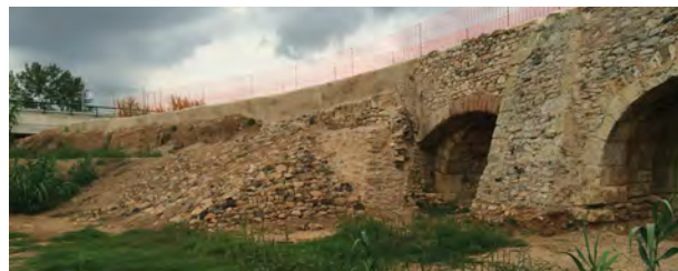
3. Parament oest en fase de restauració.
