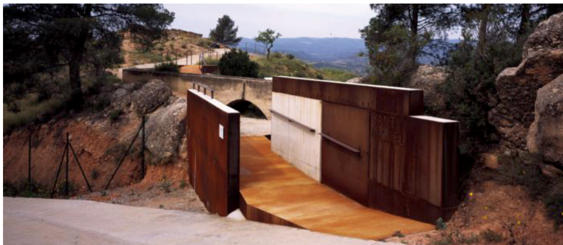
1. Porta d'accés al recinte.
