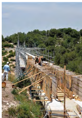
2. Reconstrucció de l'anca sud del pont.
