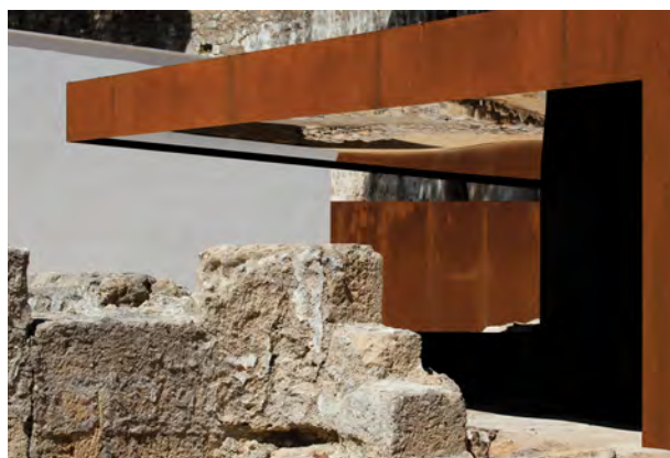
10. Estrutura de protecção dos pavimentos do Palácio dos Bispos de Lisboa
