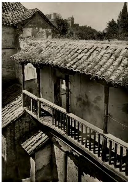
1. Vista del patio norte de la Casa del Chapiz, mirando hacia el suroeste, 1929.
