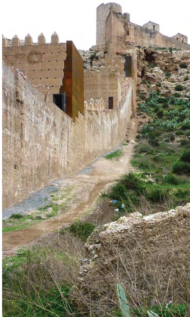
1. Estado final de la torre H8, después de la restauración.
