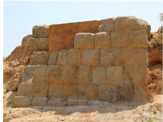
2. Torre 18 després de la intervenció.
