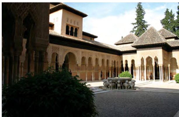
2. Vista general del Patio de los Leones antes de la intervención, 2006.
