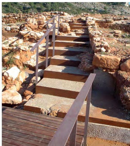
3. Reconstrucció d'escales a l'interior de l'assentament.
