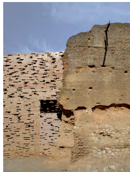
3. Vista del exterior de la muralla
