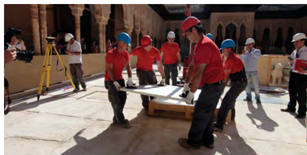
6. Colocación de un tablero de mármol en el patio por varios operarios, 2012.
