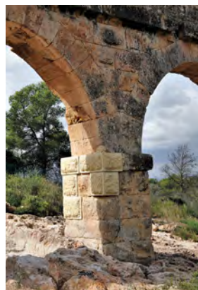
4. Estat final del pilar .
