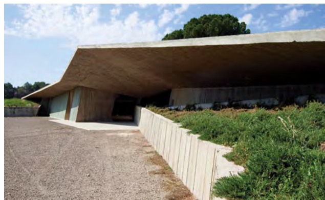
5. Vista de l'exterior de l'edifici.
