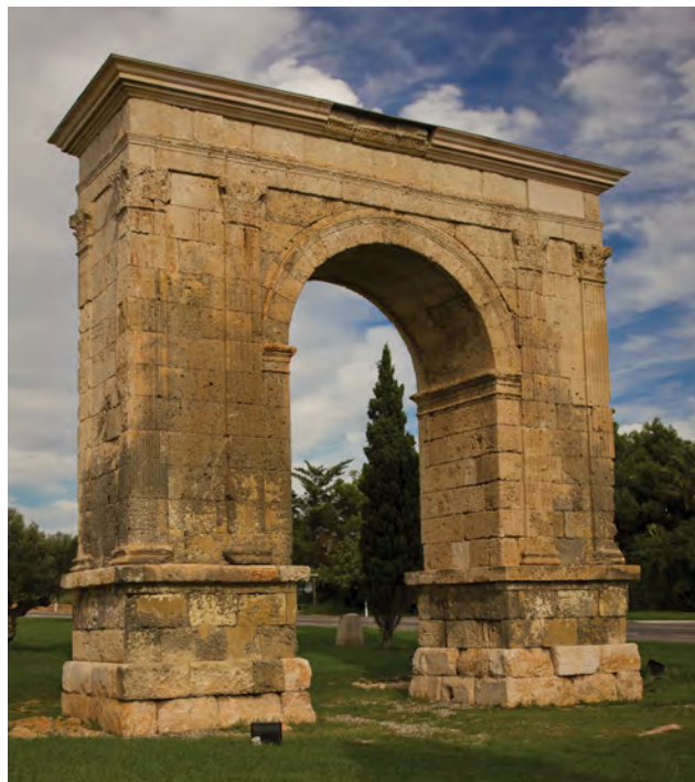
1. Restauració de l'Arc de Berà 1994-1997, façanes sud-oest i nord-oest.
