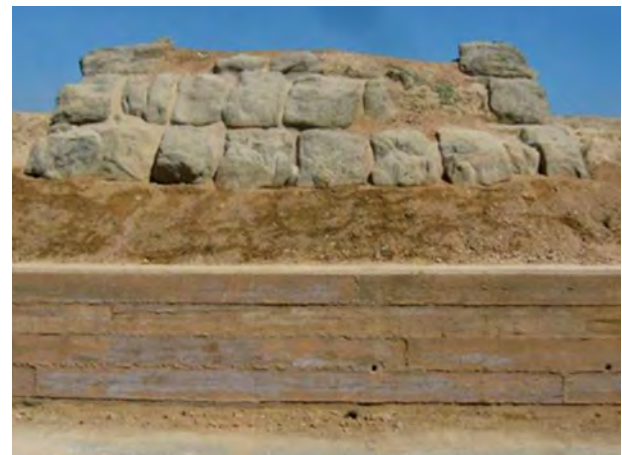
3. Torre 11 després de la intervenció.
