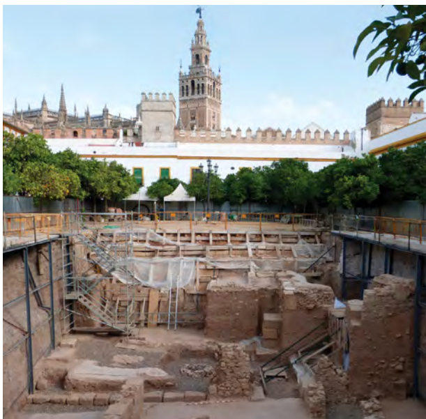
1. Protección del yacimiento y construcción de la cripta.
