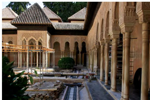
4. Nuevas instalaciones del circuito hidráulico sobre el lecho de bolos de piedra de las artesas del patio, 2011.
