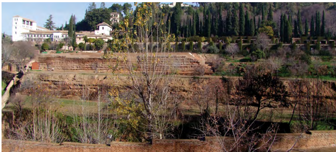
3. Vista general del muro 1 de las huertas del Generalife tras su restauración (2011).
