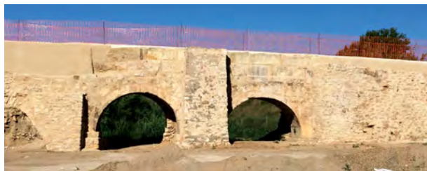
2. Parament est en fase de restauració.
