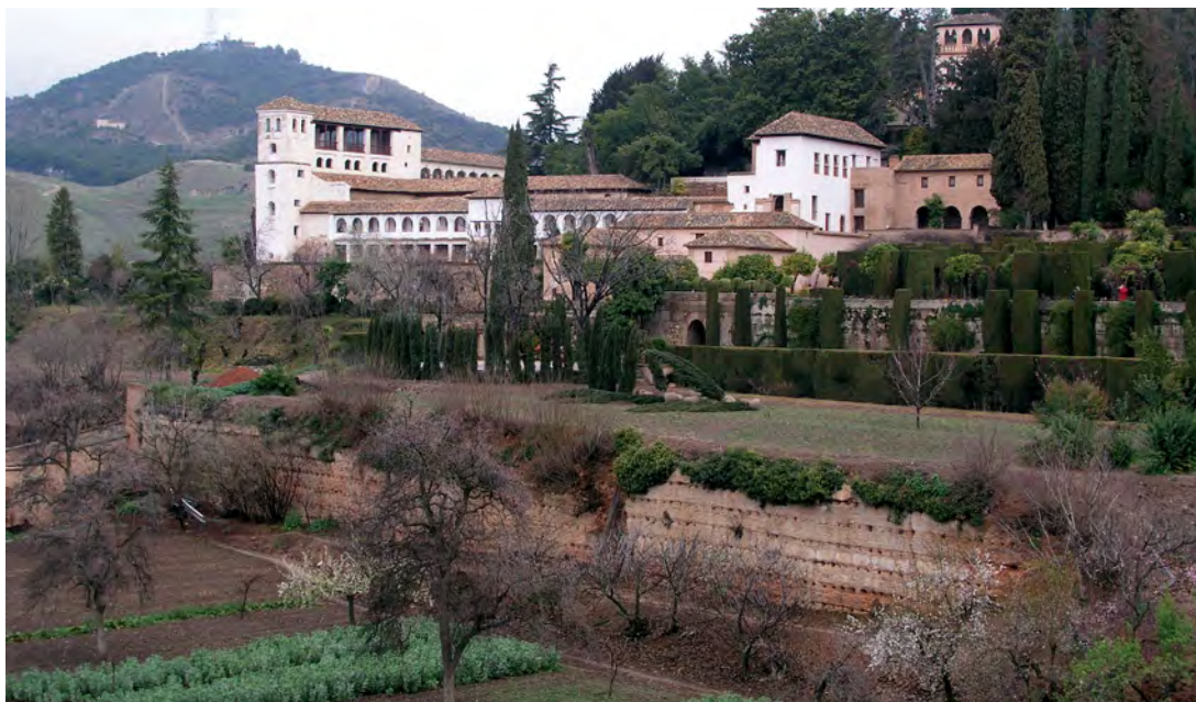
2. Vista general del muro 1 de las huertas del Generalife antes de su restauración (2007).
