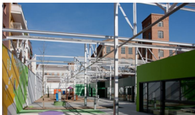
Escola Bressol Municipal La Filadora. Marc Tomas
