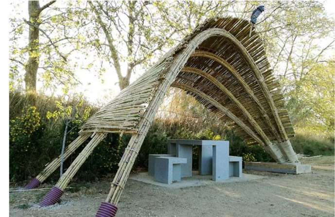
Empresa Cooperativa Voltes. Referencia de contacto con el suelo
