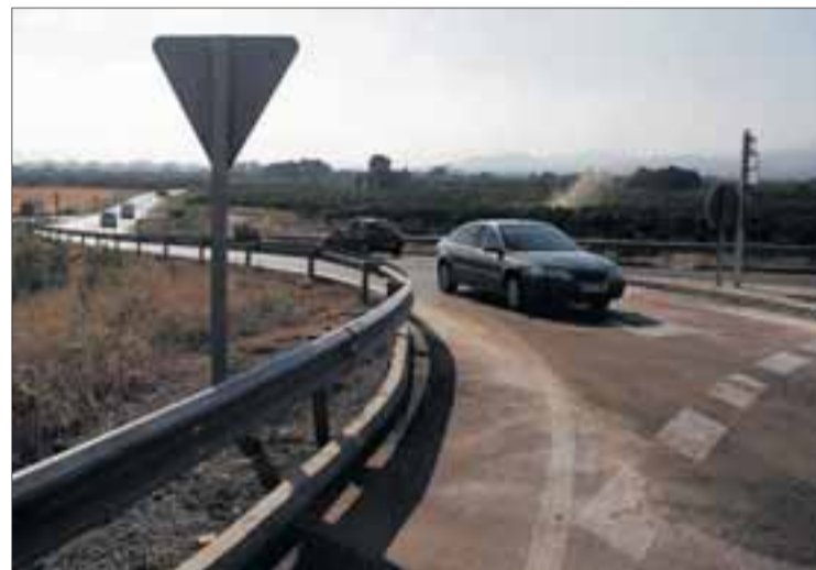
Imagen de la carretera secundaria que une el municipio de Constantí con la ciudad de Reus. FOTO:DT
