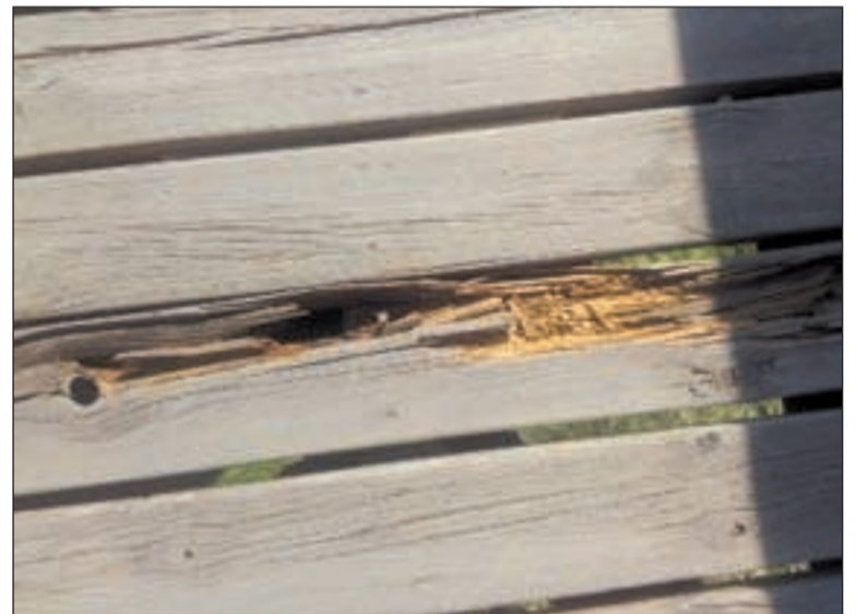
FOTO: D.A. / La Passarel·la d'en Tòfol, que salva el río entre Copa d'Or y Rufeá, tiene varios tabloncillos de su base dañados
