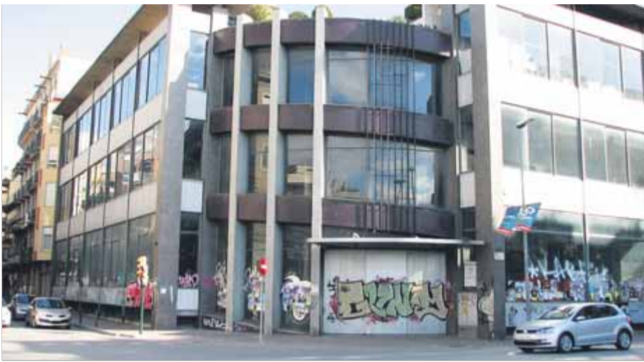
L'edifici del garatge Forné de Girona, al carrer Barcelona ■ Ò. PINILLA
