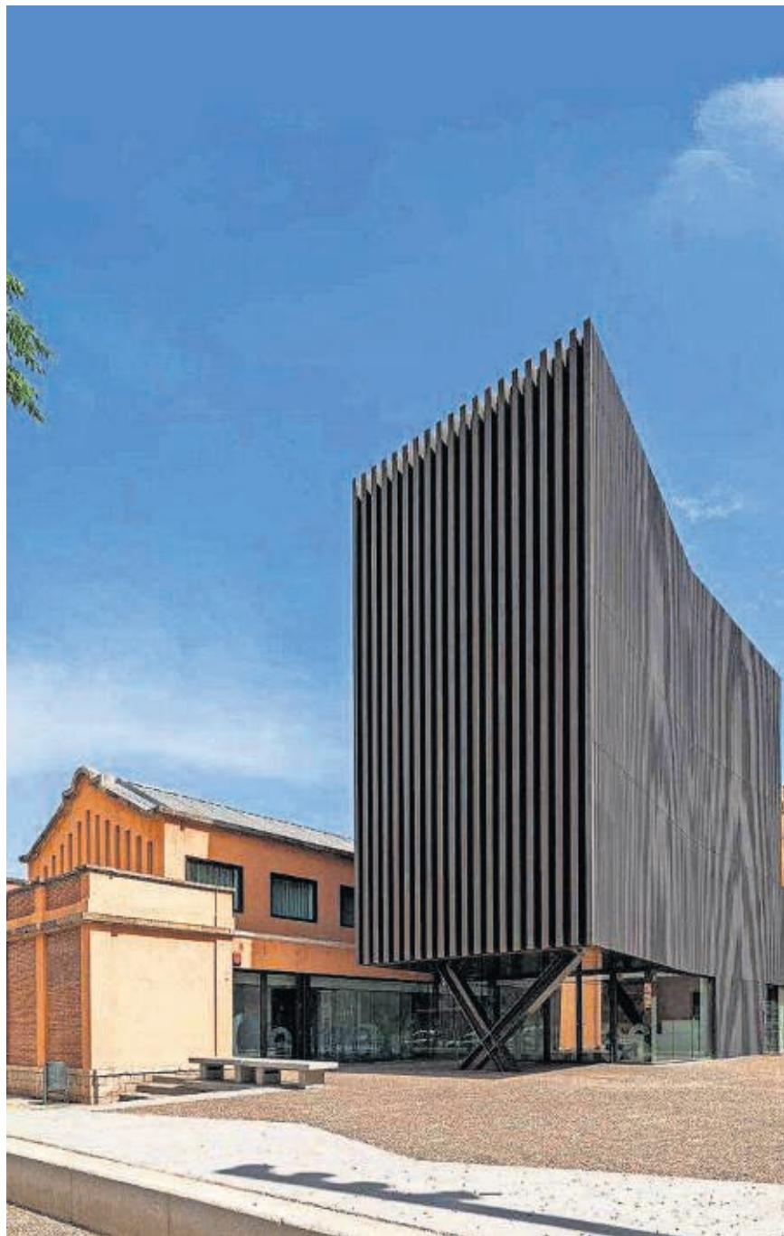
A Tortosa, l'antic mercat del barri de Ferreries va ser reconvertit en un centre cultural. La solució va ser crear un nou volum que contrasta amb el vell edifici. A sota, Lluís Casals, autor de la majoria de les imatges del llibre.
