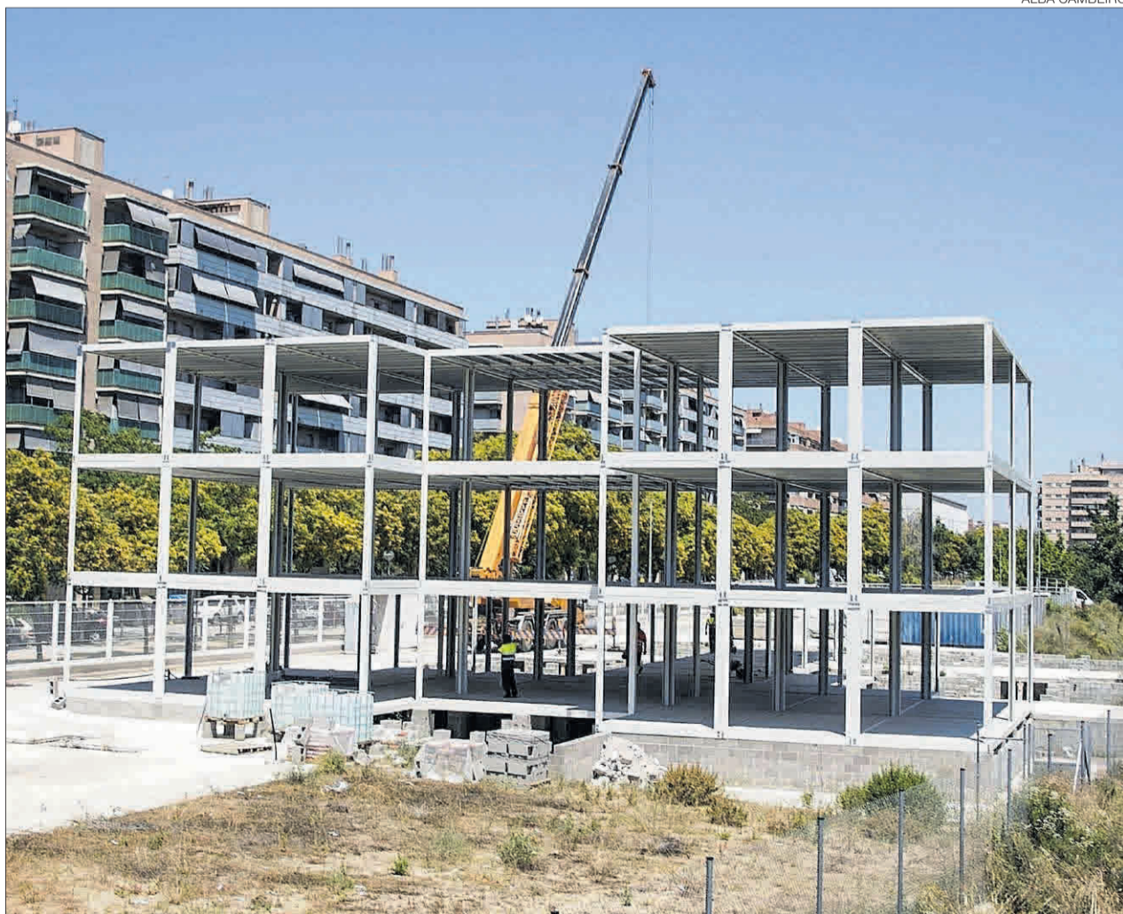
►► Edifici en construcció a Barcelona.
