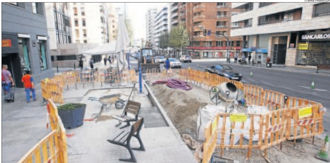
Estat actual de les obres a l'avinguda Catalunya.
