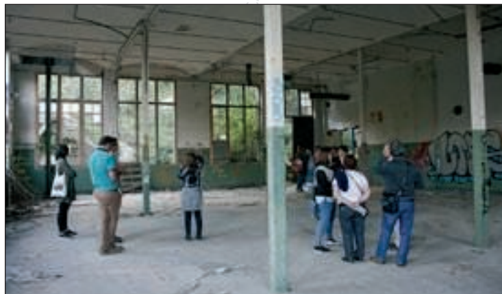
Detalls de l'estat de l'edifici i el grup del Col·legi d'Arquitectes, en la visita
