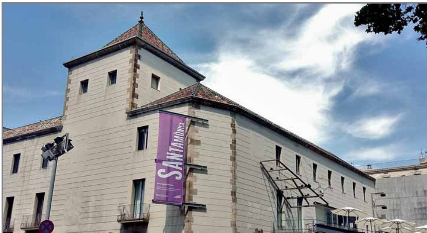
Façana del centre Arts Santa Mònica ARXIU
