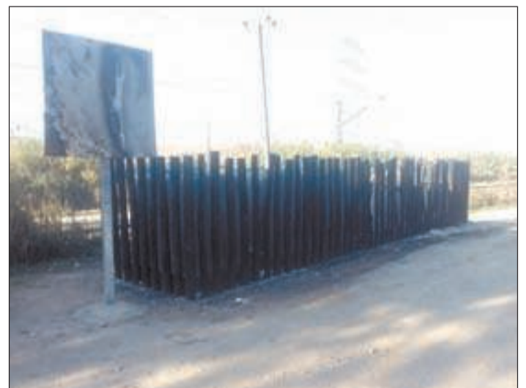
FOTO: L.M. / El área de Grealó sigue dañada por los incendios
