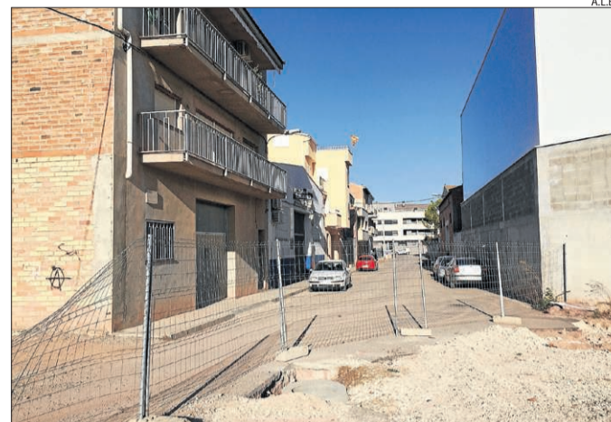
Imatge de les obres per al nou col·lector a les Borges.
