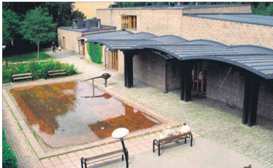
Una de les imatges captades per J.M. Torra de l’obra arquitectònica de Leverentz ■ COAC
