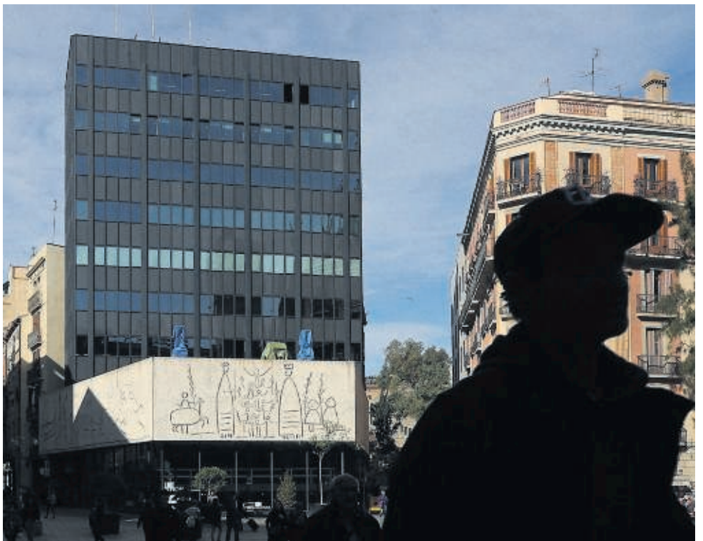
La nova façana del CoAC, exemple barceloní clàssic de mur cortina . / JOAN SÁNCHEZ
