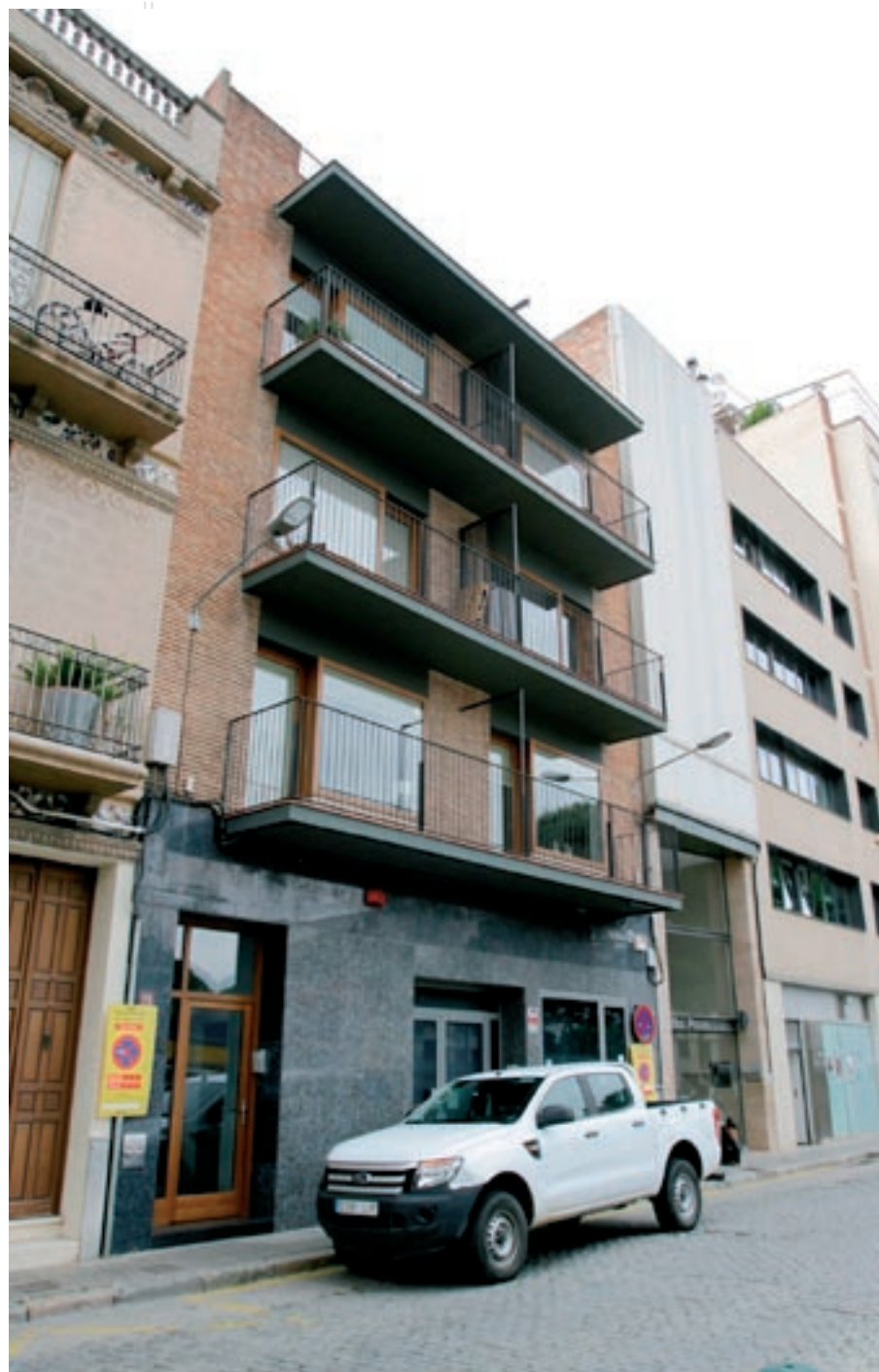
S'han renovat totalment els habitatges del bloc de la plaça Pau Casals construït als seixanta
