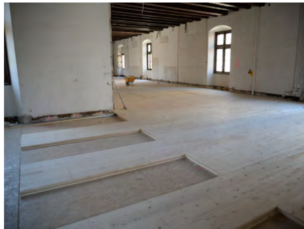
Reforç del sostre
