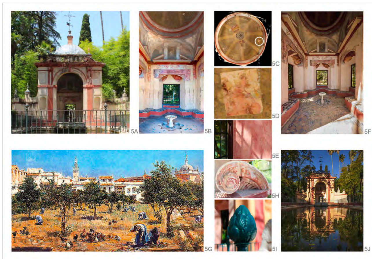
Figura 5. En busca del color y pinturas del Cenador del León. 5A) Fotografía del estado antes de la intervención. Consecuencia de acciones destructivas ocasionadas por los efectos del agua y de anteriores intervenciones, solo quedaban vistos unos pocos restos de revestimiento original. 5B) Fotografía del estado antes de la intervención. En el interior del cenador la humedad por capilaridad había deteriorado las partes bajas de los revestimientos. 5C y 5D) Los estudios científicos y las catas depararon sorprendentes pinturas al fresco originales ocultas, con bellos dibujos y delicados colores, como el maravilloso ángel niño que había sido cubierto por otras pinturas, probablemente neoclásicas, del siglo XIX. En el archivo del Real Alcázar se localizó la memoria del pintor Juan de Medina presentada el 11 de enero de 1646 y la certificación del veedor Esteban de Mendoza. Estos dos documentos analizados por la profesora Marín Fidalgo permitieron datar las pinturas entre noviembre de 1644 y enero de 1646 y conocer los temas de la ornamentación, dedicados al amor y protagonizados por dioses, cupidos y ninfas. En el interior están a la vista algunos restos originales, otros están cubiertos por pinturas posteriores y los demás no se conservan. La decoración pictórica del exterior ha desaparecido por completo. 5E) En el interior, donde se perdieron las pinturas, se aplicó mortero de cal y estuco, con un acabado muy sutil con pigmentos minerales en el que se utilizó, para la reintegración cromática, el criterio de abstracción con los colores usados por Juan de Medina. 5F) Estado de las pinturas del interior después de la restauración. 5G) En el óleo de José Villegas Cordero, 1895 [colección particular, Madrid], los colores del cenador coinciden con los descritos por Juan de Medina y con las pinturas de las enjutas de los arcos interiores. 5H) Restos de estucos en el frontón curvo abierto. 5I y 5J) Fotografías después de la intervención. La restauración del pabellón consiguió devolver al Cenador del León la atmósfera otorgada por Juan de Medina, con lo que se logró la armonía cromática con los demás elementos del jardín. La restauración se realizó en 2017 y 2018.
