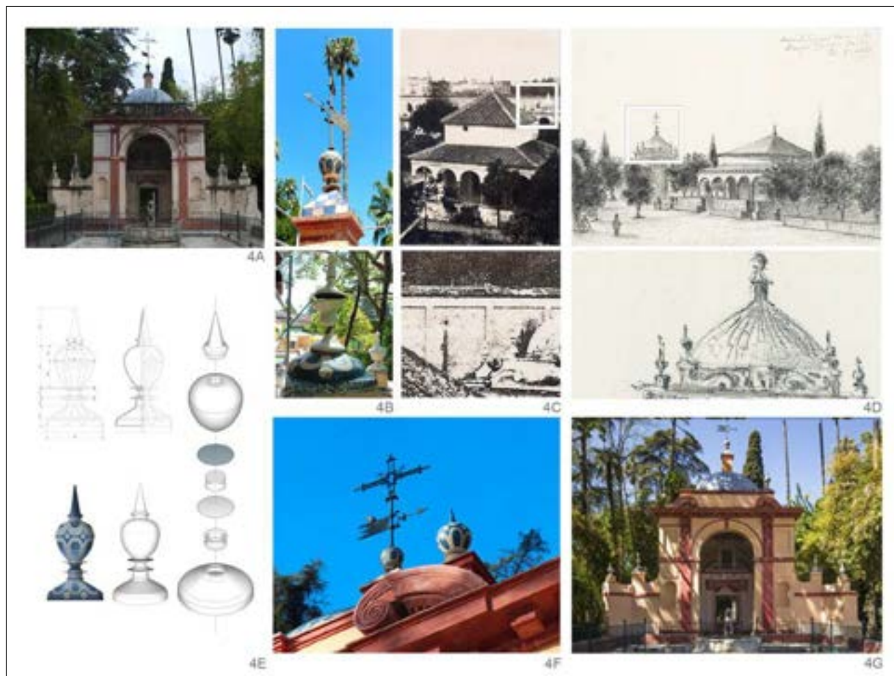
Figura 4. Recuperación de los pináculos cerámicos de Benito Valladares en el Cenador del León. 4A) Fotografía del estado antes de la intervención. Los cuatro pináculos esquineros originales que remataban la cubierta fueron sustituidos por otros neoclásicos que se encontraban muy degradados. 4B) De aquellos originales del siglo XVII se conservaban restos materiales: dos basas y el remate completo de la veleta. La datación de estas piezas cerámicas se realizó a través de la certificación del veedor Esteban de Mendoza, conservada en el Archivo del Real Alcázar, donde se indica que, entre 1645 y 1646, Benito Valladares vendió al Alcázar azulejos, ladrillos y catorce bolas grandes «con todas sus adherentes» para los cenadores del León y el Ochavado. 4C y 4D) Numerosas fotos históricas y dibujos confirmaron que los pináculos fueron sustituidos, con lo que varió el diseño y la ubicación. Entre las fuentes gráficas destaca una fotografía del Vizconde de Vigier, 1850-1851, de la colección Duque de Segorbe y el dibujo a lápiz de Richard Ford, colección de la familia Ford, Londres. 4E) Los restos conservados in situ de los diferentes elementos que conforman estos remates permitieron realizar el diseño de los nuevos pináculos siguiendo los originales de Valladares. 4F y 4G) Fotografía después de la intervención. Nuevos pináculos esquineros ornamentando el Cenador del León. La restauración se realizó en 2017 y 2018.
