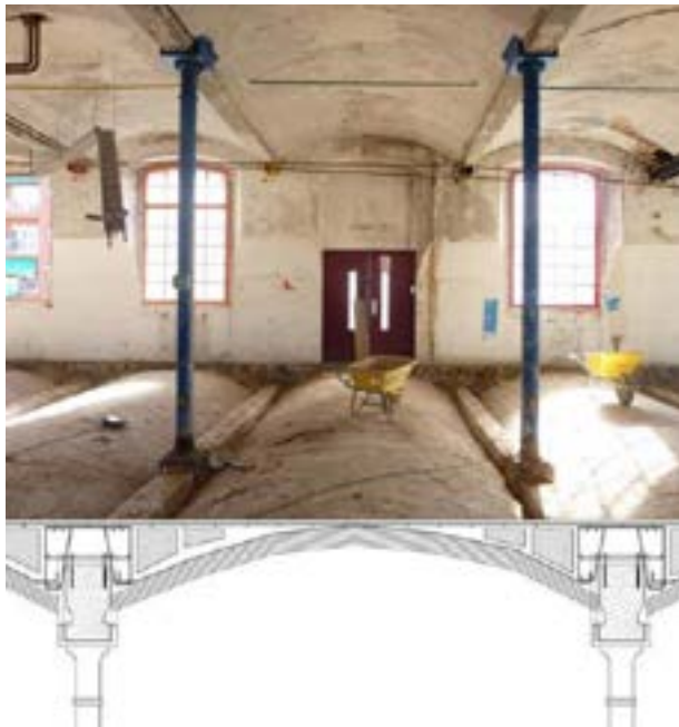
Imagen 5. La estructura. Plano sección de proyecto ejecutivo.
