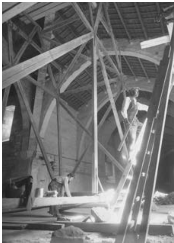
Obres de restauració de l'antic Hospital de la Santa Creu de Barcelona per acollir la nova seu de la Biblioteca de Catalunya (c. 1931-1936). Foto G. Casas i Galobardes. Arxiu Nacional de Catalunya.
