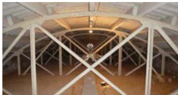
Figura 5. Interior de la cambra sota coberta de la Biblioteca
