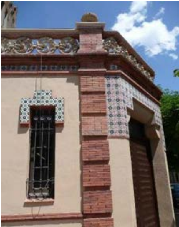
Reparació del sostre de la biblioteca de Can Casas. 2001. Intervenció
