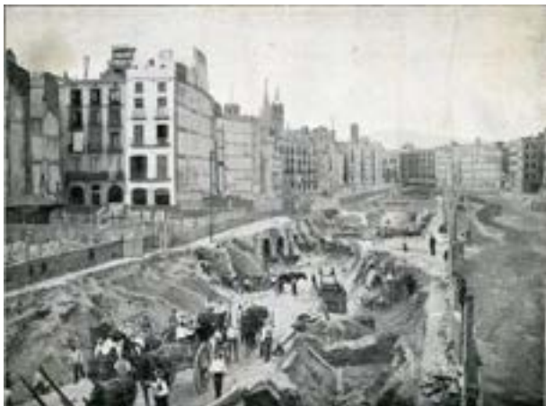
Figura 5. Reforma Interior de Barcelona. Obertura de la Via Laietana i túnel del Metro. Frederic Juandó Alegret, 1911. SCCM-SPAL. Diputació de Barcelona
