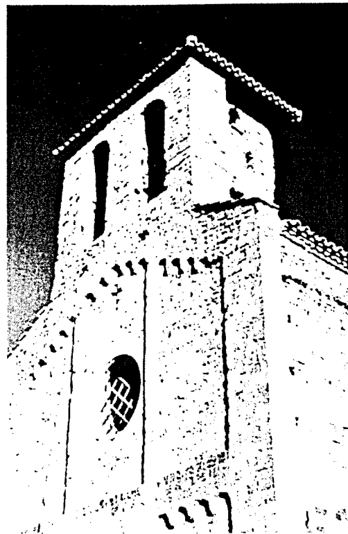
El reconstruït campanar d'espadanya que presideix la façana de l'Església de Sant Jaume de Frontanyà.
