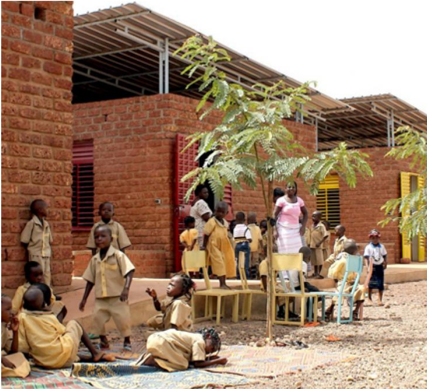
[1] Imatge: © Llar d'infants Laafi, Burkina Faso. Albert Faus Madrid. Projecte seleccionat a la 1a Mostra d'Arquitectura Internacional.
