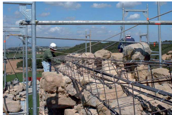
Restauració al segle xx. Irrupció del formigó armat.
