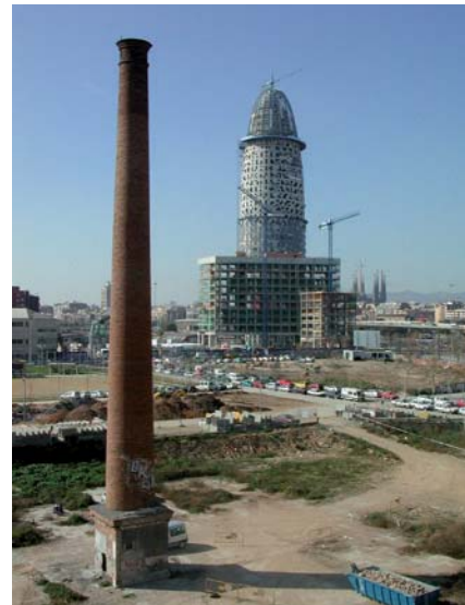
Torre Agbar en construcció i xemeneia del Poblenou.
