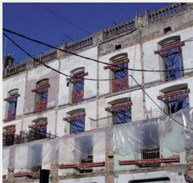
Trasdós de la façana anterior un cop enderrocat tot l'interior de l'edifici per a l'ampliació de l'Ajuntament.
