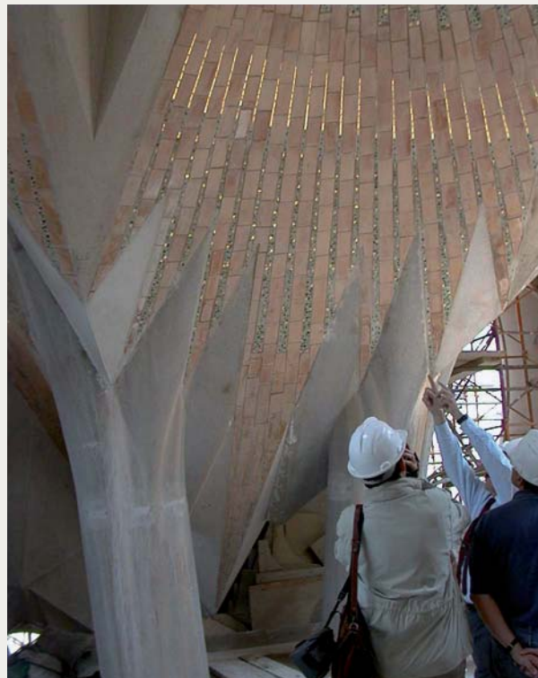
Visita a les obres de la Sagrada Família.
