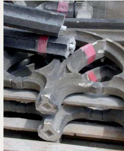
Visita a les obres de restauració de la Catedral de Barcelona. Detall del sistema d'encaix entre els elements de pedra treballada.
