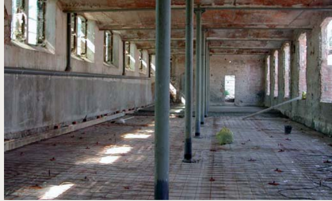
Reforç estructural d'un sostre a Ca l'Aranyó.
