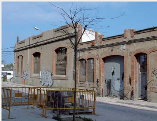
A l'esquerra, edifici d'oficines i accés principal al conjunt fabril, al carrer Perelló. 23 de setembre del 2003. A la dreta, enderroc parcial de la façana del carrer Perelló. Abril del 2005.
