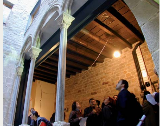
Visita a les obres de la restauració dels antics palaus gòtics del carrer del Lledó.
