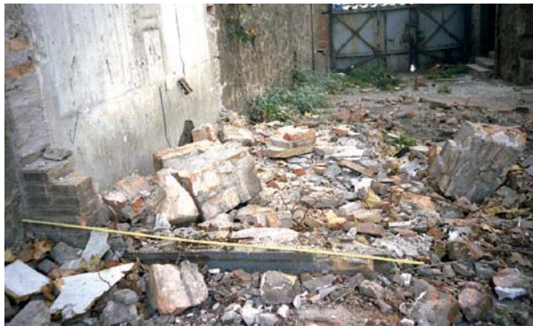
Enderroc de la caseta de la porteria l'any 2002.
