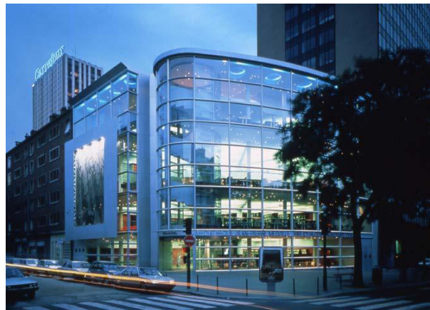
Bibliothèque Jean-Pierre Melleville 93 rue de Tolbiac - Paris 13e / Maîtrise d'ouvrage : Ville de Paris / Surface : 3 500 M 2 SHON / Ouvert au public : 1989
