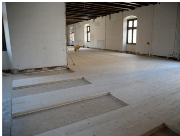
Reforç del sostre
