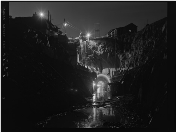
Figura 2. Pando, Juan. Canal de Orellana. Obras de construcción de un túnel del canal de regantes de la presa y embalse de Orellana, en la cuenca hidrográfica del Guadiana. 1963
