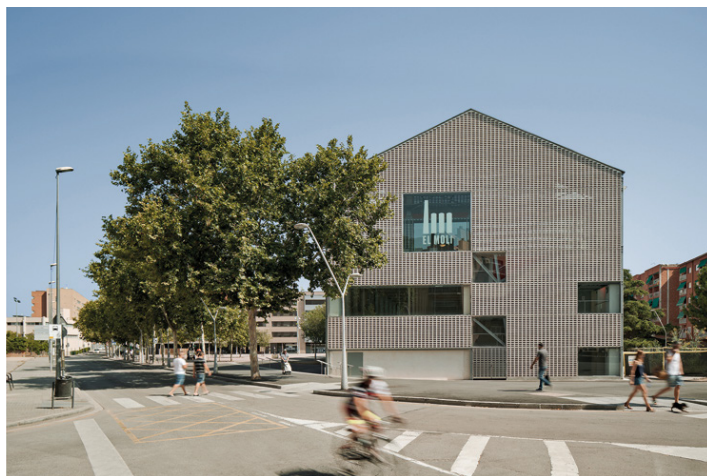
Imagen 4. La fachada. El paseo del Terraplé tropieza con la fábrica. Para garantizar la sección completa de este eje público, se propone un apeo de la esquina del edificio, un voladizo que garantice la continuidad de toda la anchura del paseo y, a través de él, el paso de la gente, el mercado, la feria.
