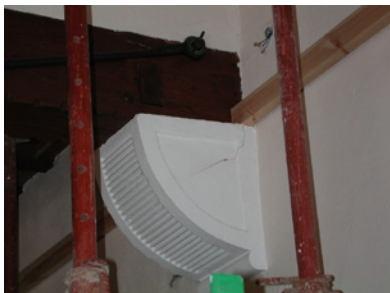
Reparació del sostre de la biblioteca de Can Casas. 2001. Patologies
