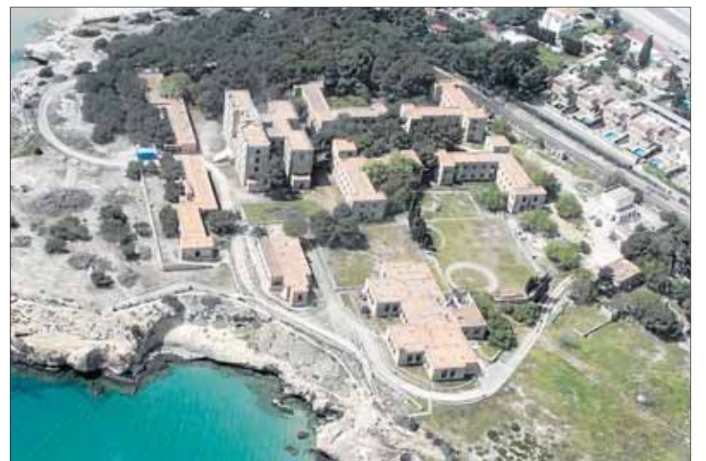
Imagen aérea del antiguo preventorio de la Savinosa, hoy abandonado a la espera de un proyecto. FOTO: PERE FERRÉ
