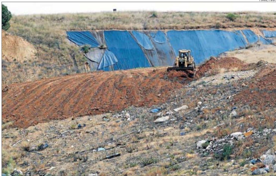
Les tasques que es van dur a terme, fa més d'un any, de cobertura dels residus.
