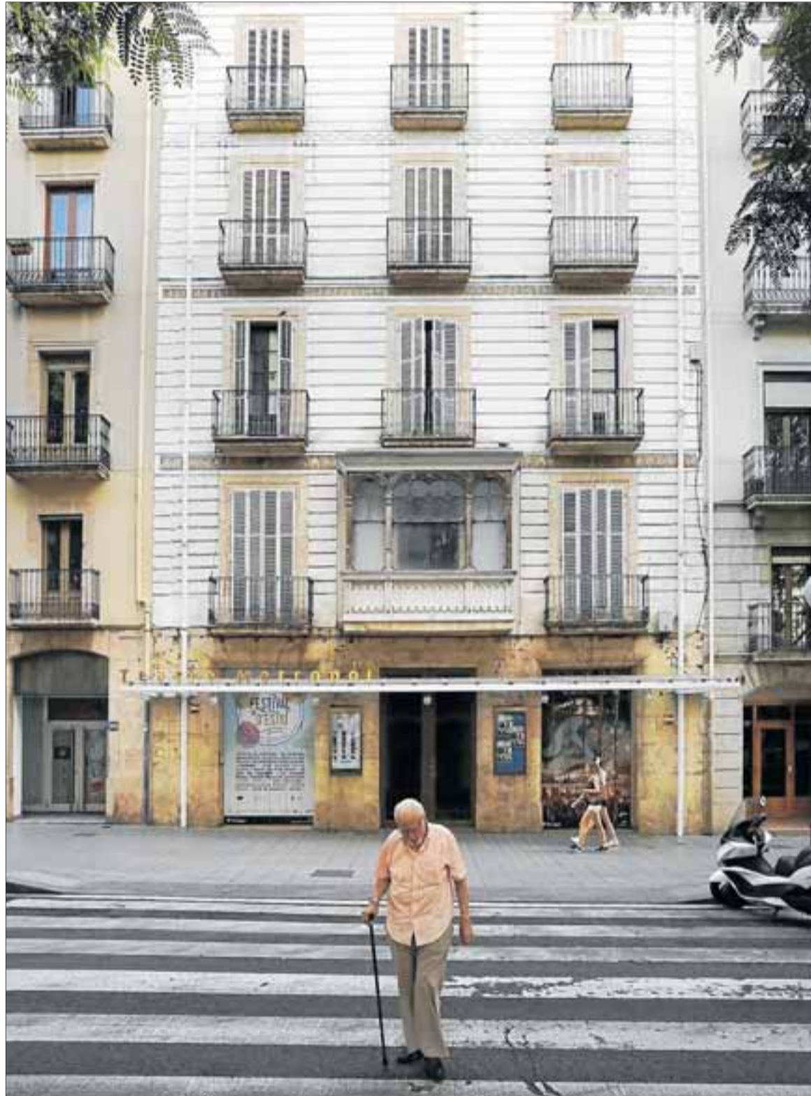
Imagen del aspecto que ofrece el edificio del Metropol, cuyas plantas superiores están vacías. FOTO: PERE FERRÉ
