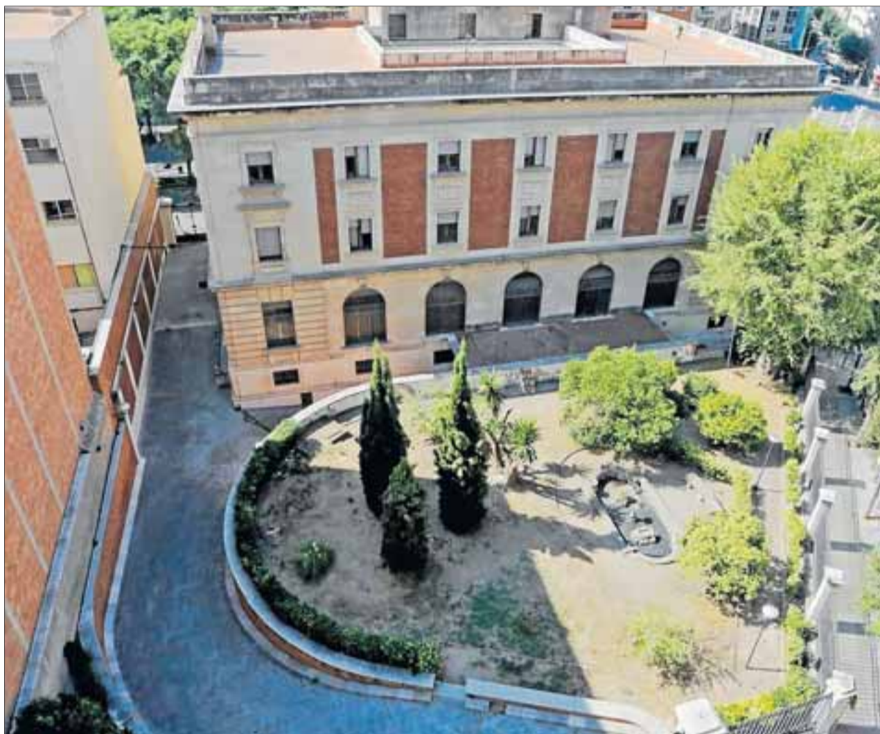
El ayuntamiento abrirá en pocos meses el jardín del edificio, que también es zona edificable. FOTO: LLUÍS MILIÁN
