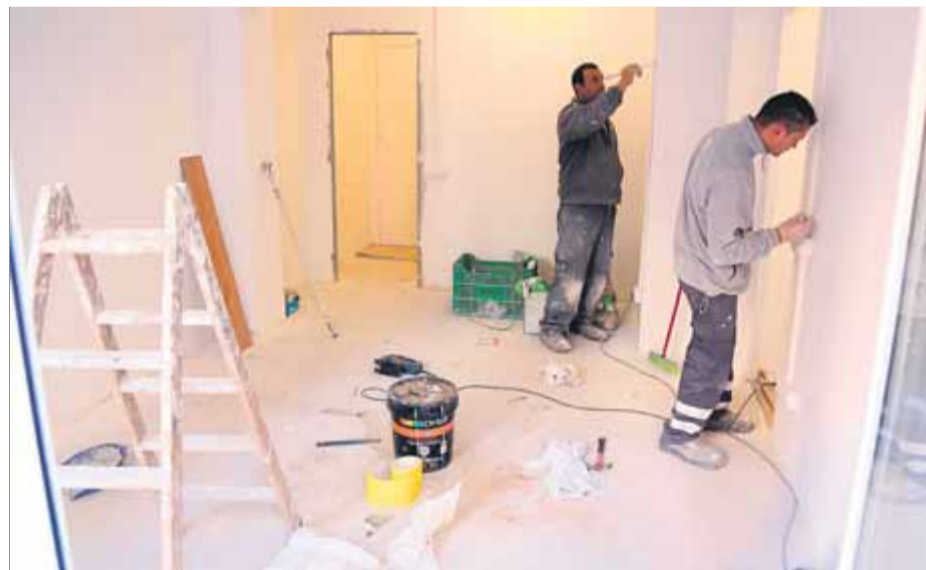
Dos treballadors de Formació i Treball fent ahir la rehabilitació d'un pis d'Hàbitat3 ■ J. RAMOS
