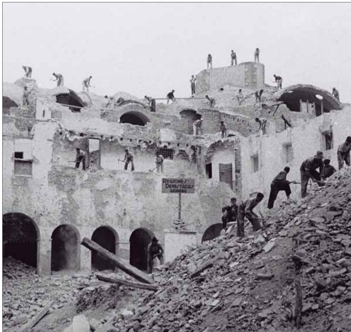
Fotografia que reflecteix l'activitat de Regiones Devastadas. Es tracta de l'enderroc (1941) de l'antic convent dels carmelitans descalços (carrer de Santa Anna, Tortosa), previ a la construcció de les actuals escoles de Remolins. FONTS J. DAUFI
