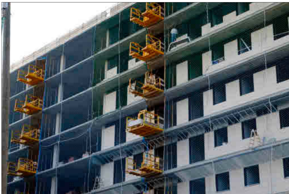
Trabajos de construcción de una obra en Barcelona. JORDI SOTERAS
